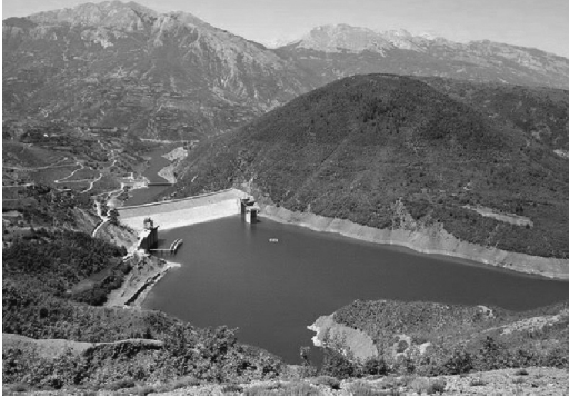
Fig. 6.30 Hidrocentrali i Fierzës
