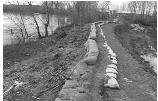
Fig. 7.33 b) Riparim i një pende të përkohshme
