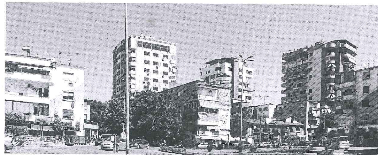
Vista dalla via Abdyl Frashëri, rotonda Wilson (fonte: l'autore)
