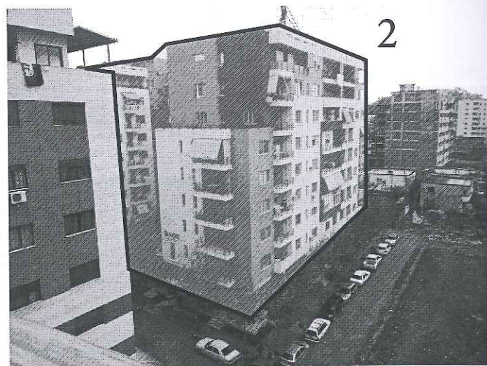
Vista dell'edificio (fonte: l'autore)
