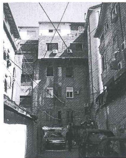
La perdita dello spazio aperto all'interno del blocco Agimi. Presenza di macchine parcheggiate e di costruzioni informali. (fonte: l'autore)
