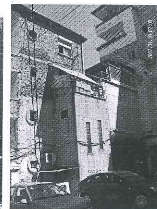
Gli interventi abusivi nelle facciate di Blloku + (nei balconi, scale, spazi aperti pubblici) e l'intrusione delle auto in ogni spazio aperto. (fonte: l'autore)
