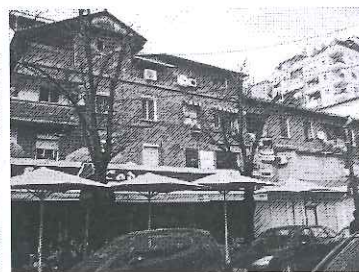
Edificio residenziale a Tirana, in via in Sami Frasher street. (fonte: l'autore)
