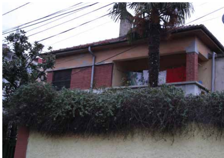
Vila nr. 25, rruga “Gjon Muzaka” / Fotografoi: G. Struga
