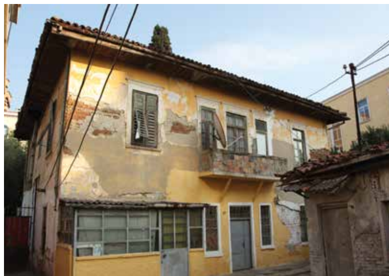
Vila nr 25, rruga "Zydi Caslli" / Fotografoi: G. Struga
