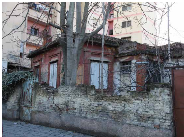
Vila nr. 30, rruga "Naim Frashëri" / Fotografoi: G. Struga
