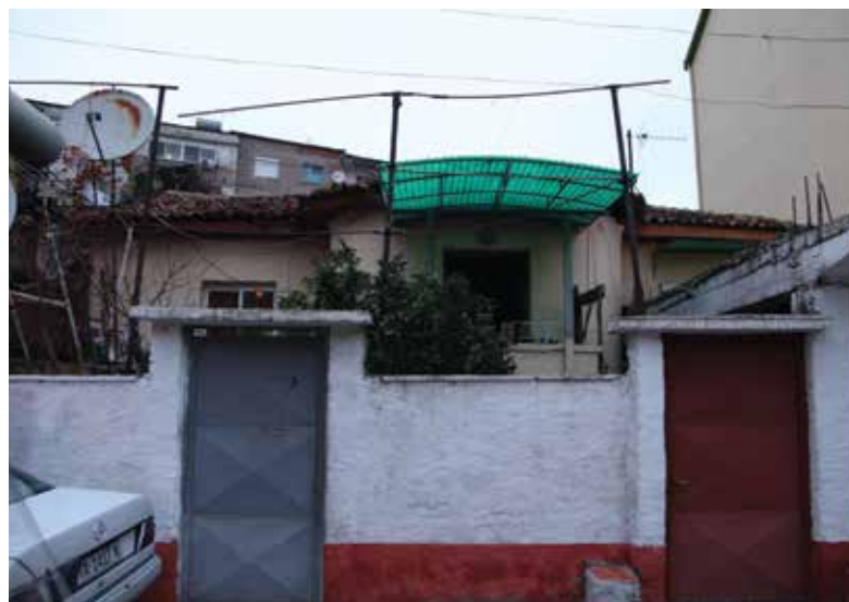
Vila nr. 23, rruga “Xhezmi Delli” / Fotografoi: G. Struga
