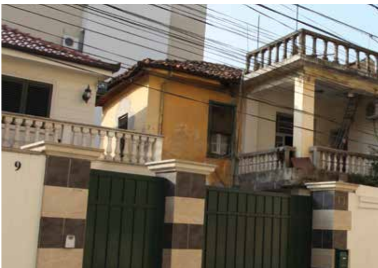
Vila nr 23, rruga "Zydi Caslli" / Fotografoi: G. Struga
