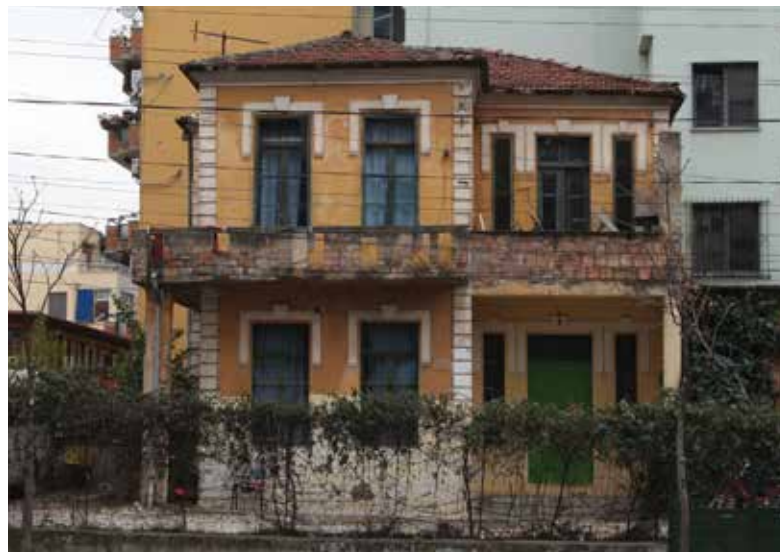
Vila nr. 11, rruga "Elbasanit" /Fotografoi:G. Struga
