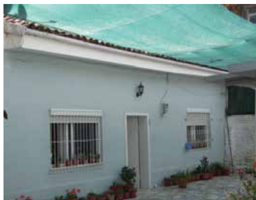
Vila nr. 59, rruga “Bargjinët”
