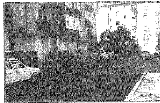
Rehabilitimi i hapësirave publike në bllokun "1 Maji", ku kontributi i komunitetit përbën 20% të kostos së projektit (nga sipër-poshtë gjendja para dhe pas rehabilitimit)
