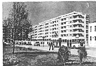
1- Apartamente banimi të ndërtuara me elemente beton / arme të parafabrikuara
