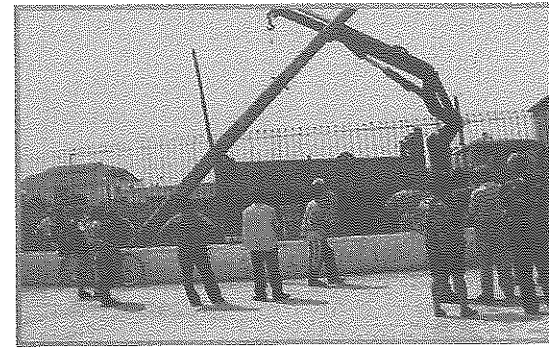
Instalimi i infrastrukturës energjitike në Breglumas, ku 95% e komunitetit ka paguar kontributin financiar.
