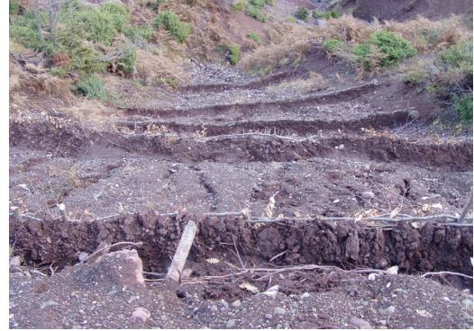
Fig. 2.95 Ndërtime gardesh antierozive
