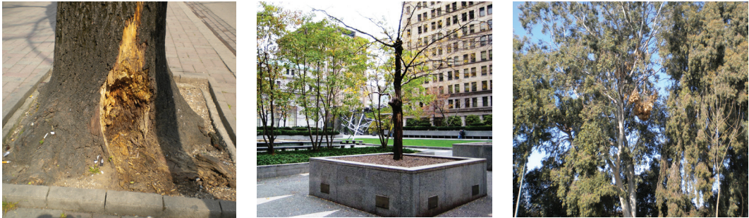
Fig. 3.18 a, b, c Drurë në gjendje jo të mirë e në degradim
