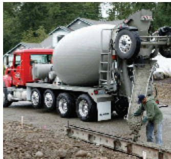
Fig. 3.21 Shpëlarja e betonierave
