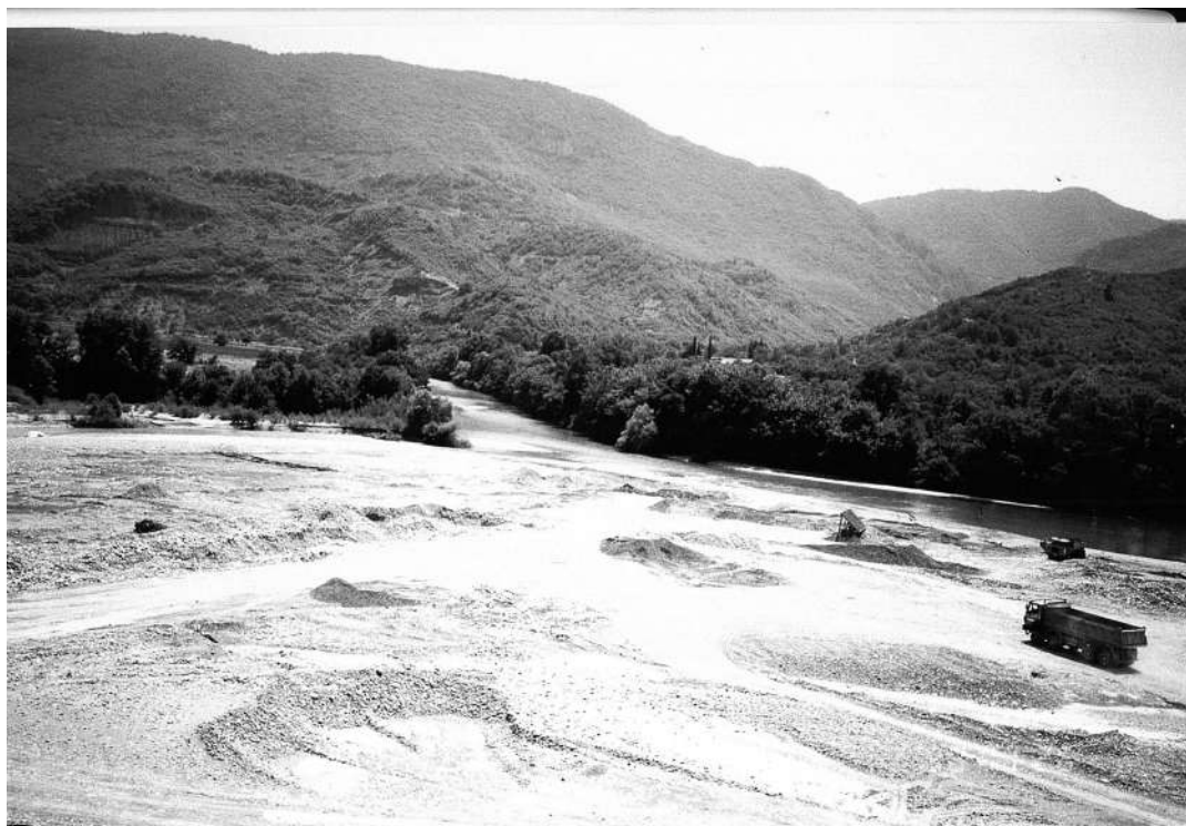
Foto IX. 16. Marrja e inerteve në lumin e Vjosës (Mesare-Përmet). N. Meçaj, 2005.
