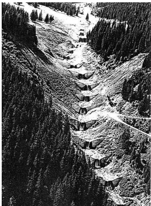
Figura X. 1. Ndërtimi i pritave malore, për mbrojtjen e qytetit e Enerbaçit në Tirolin lindor, Austri.
