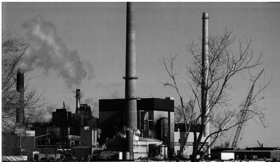
Foto IV. 11. Ndërtimi i oxhaqeve te larta për të reduktuar koncentrimin e ajrit të ndotur në qendrat e banuara.
