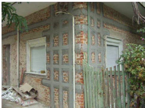
Figura 3.8 – Aplikime të përforcimit me FRP të strukturës me muraturë(www.angelobiondi.com) [8]
