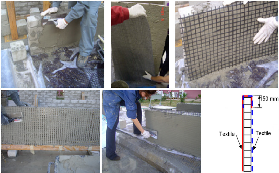
Figura 3.13 Aplikime praktike të teknikës TRM (Construction and Building Materials, 2011) [20]
