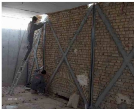
Figura 3.8 – Aplikime të përforcimit me FRP të strukturës me muraturë(www.angelobiondi.com) [8]
