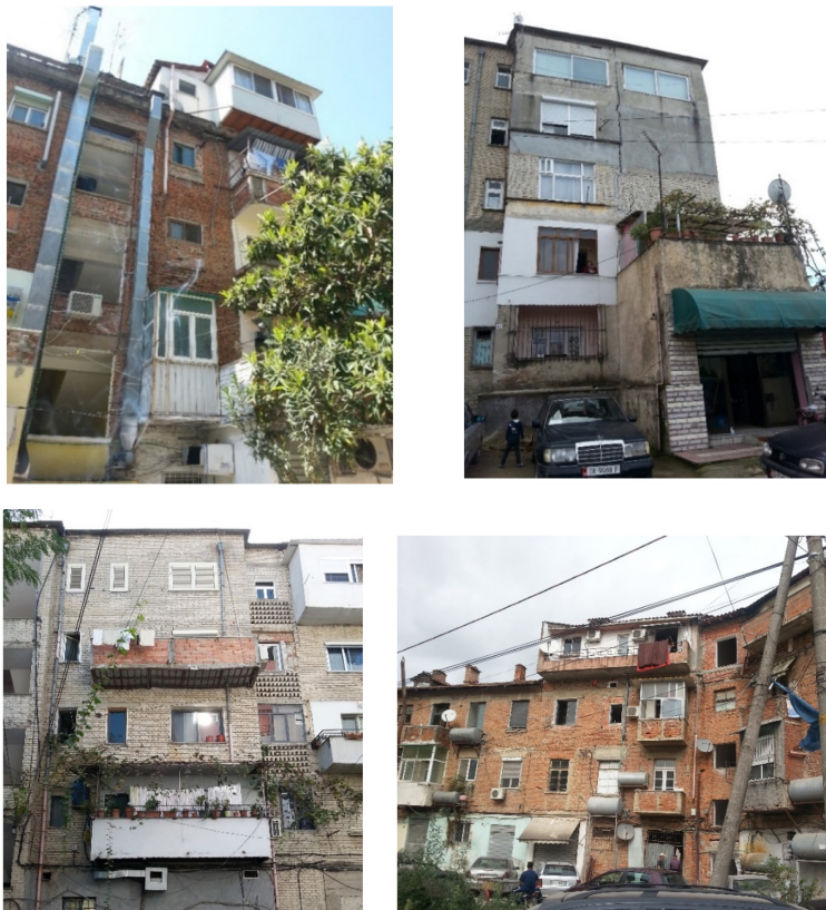
Figure 2.5 – Ndërhyrjet pa kritet në strukturat me muraturë (foto autori nga objektet në Tiranë)
