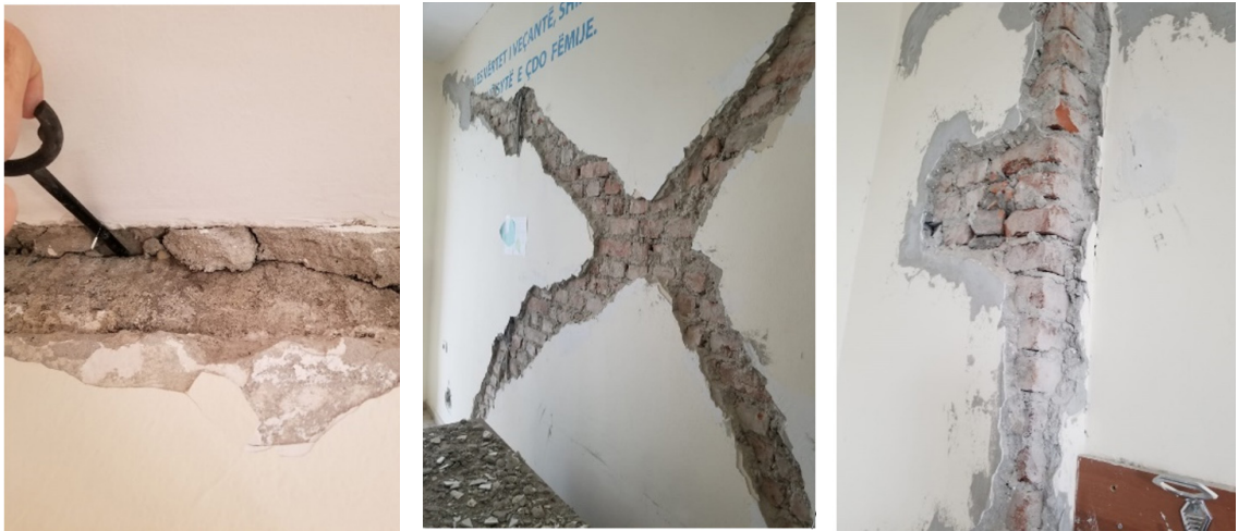
Figura 2.8 – Çarje vertikale tek bashkimi i murit gjatësor dhe tërthor (a) dëmtim nga forca prerëse (b) dëmtim diagonal i murit (c) (foto autori)
