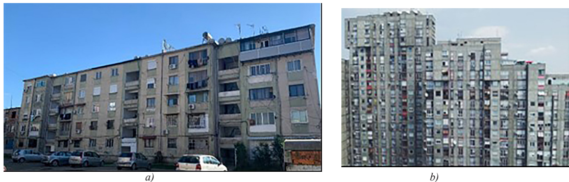
Figura 42. Shembuj të ndërtesave me pllaka beton arme të parafabrikuara: a) Zona e Kombinatit, Tiranë, Shqipëri dhe b) Blloku 63, Beogradi i Ri, Serbi
