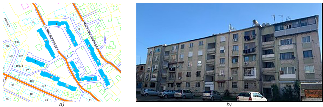
Figura 34. Ndërtesat me pllaka beton arme të parafabrikuara në zonën e Kombinatit të Tiranës: a) një hartë që tregon ndërtesat me pllaka beton arme të parafabrikuara – shënimi i ndërtesës nr. 12 të mbyllur nga një rreth dhe b) një imazh i pamjes së fasadës për ndërtesën nr. 12 (burimi: AQTN)
