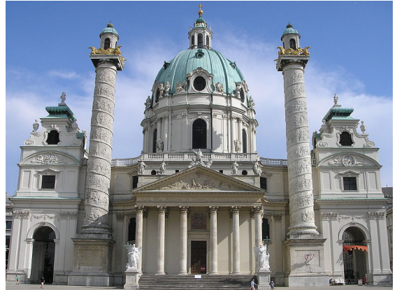
8-28. Shën Karli Borrome në Vienë, fasada kryesore
