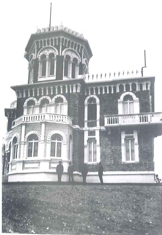
Dieses Gebäude wurde vom Architekten Kristo Sotiri entworfen, später durch das von Florestano Di Fausto entworfene Gebäude ersetzt This building designed by architect Kristo Sotiri was later on substituted by the building designed by Florestano Di Fausto
