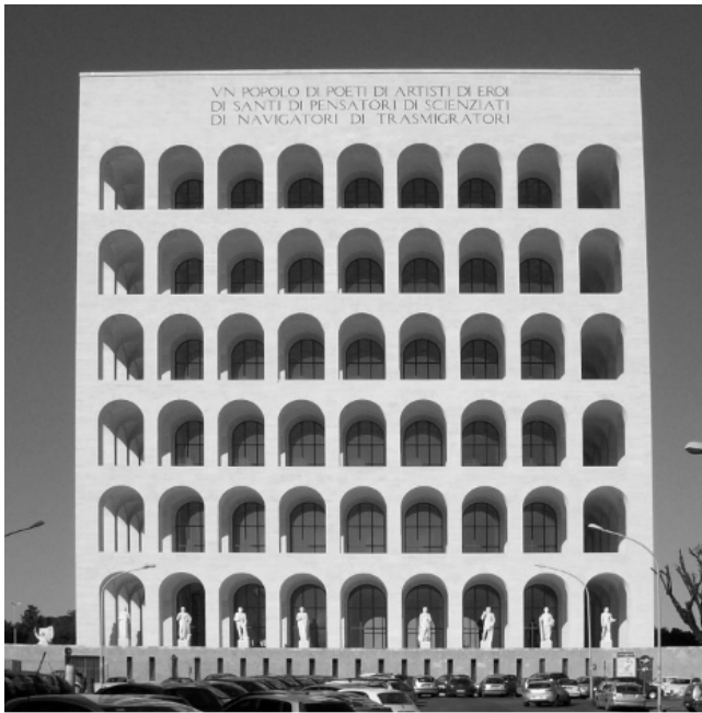
Figure 4. Photo of Palazzo della Civiltà Italiana (Photo by Author: 2023)
