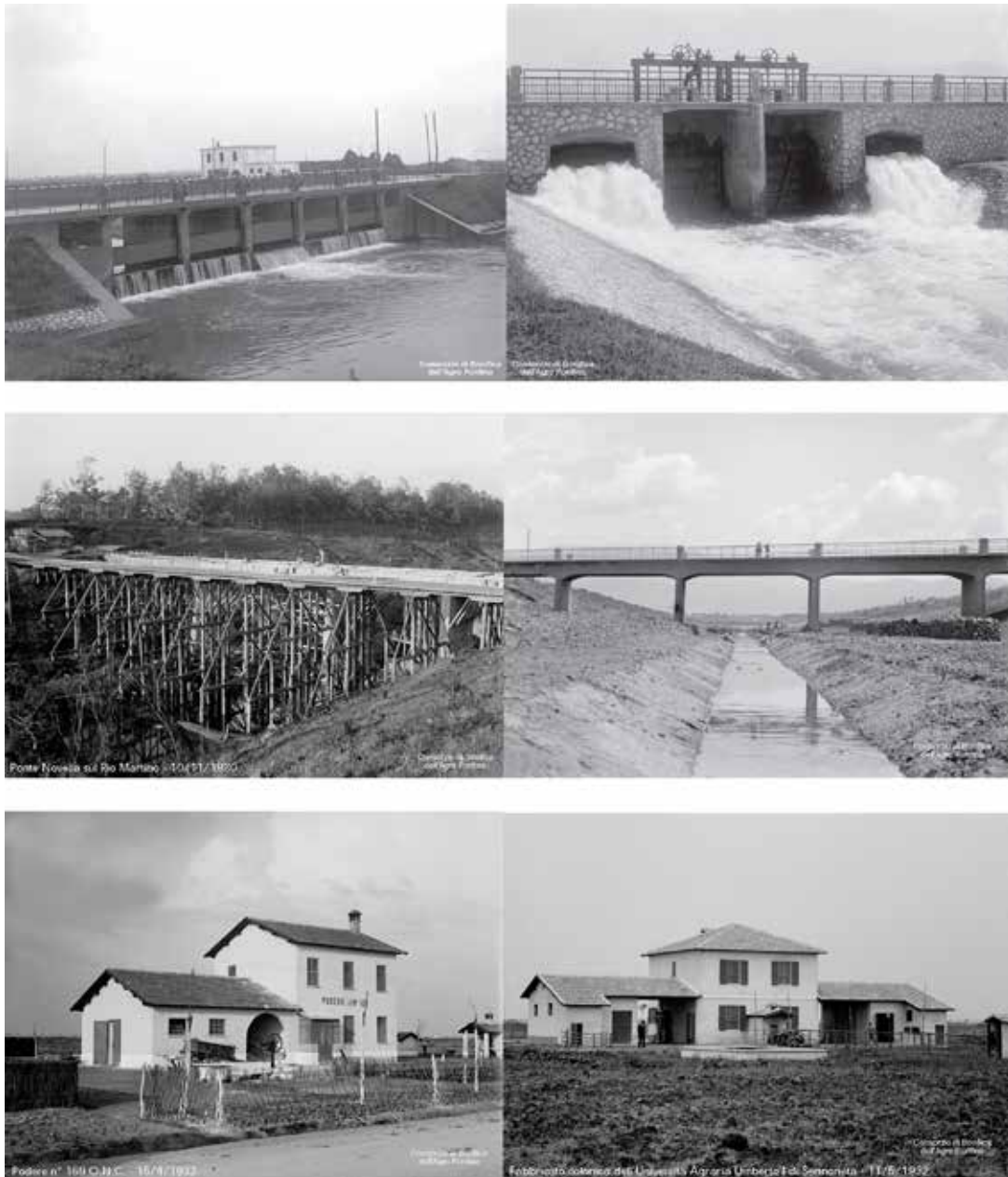
Figure 2 Evidence of reclamation: the canal locks, the bridges and the houses, Archive of the Land Reclamation Consortium, Latina (Fondo fotografico Archivio Consorzio di Bonifica dell'Agro Pontino Latina)
