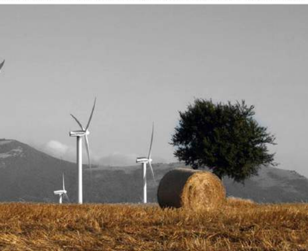
IMPIANTI MICRO EOLICI, PER DARE ENERGIA AL TERRITORIO
