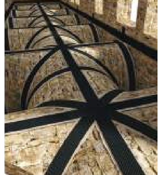
Aplikim përforcimi solet me lamine fida karboni (CFRP).
