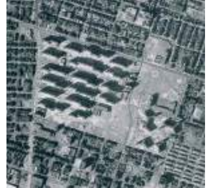
Ansambli i banesave Pruitt-igoe, St. Louis, seria e fotove të shembjes viti 1971 http://upload.wikimedia.org/wikipedia/commons/9/98/Pruitt-igoe_collapse-series.jpg
